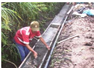
Gambar 1. Saat Pemlesteran Permukaan Saluran Drainase Jalan Desa
