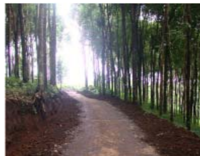
Gambar 3. Pada Saat Awal Penggalian Untuk Saluran Drainase Jalan Desa
