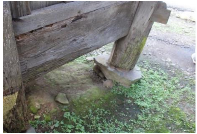
Gambar 3. Sebaran Batu Sendi Situs Batu Patah (atas), Penggunaan Batu Sendi pada Konstruksi Bangunan Tradisional Kerinci (bawah) (Sumber: Balai Arkeologi Palembang, 2009, Penulis, 2023)
