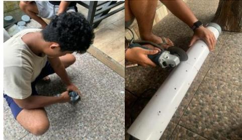
**Gambar 2.** Persiapan pembuatan lubang biopori menggunakan pipa paralon
