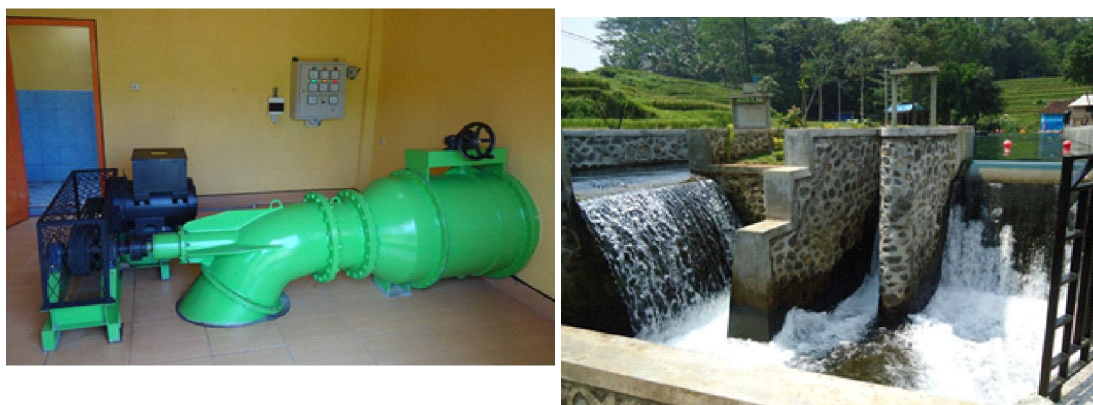
Gambar 3. Bendungan dan Turbin Propeller pada PLTMH
