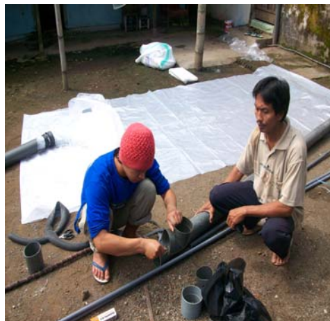
Pengerjaan Penyambungan Instalasi Biogas
