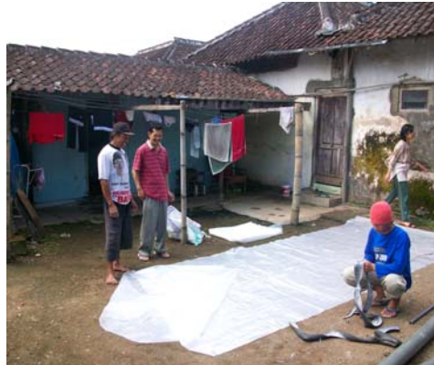
Persiapan Pipa dan Plastik Digester sebelum Dipasang
