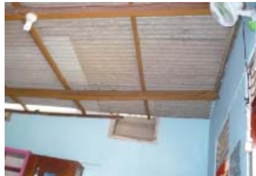
Gambar 10 Pemasangan modul 1 untuk lampu penerangan di dalam ruang perpustakaan balai Desa Jombok
