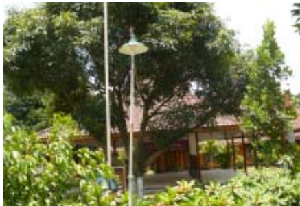
Gambar 6. Pemasangan lampu penerangan jalan dan bagian luar gedung pertemuan dengan menggunakan modul 3 di balai Desa Jombok
