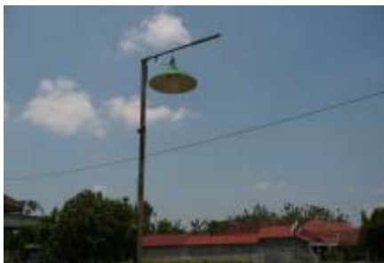
Gambar 7. Anggota tim sedang melakukan cek hasil pemasangan lampu penerangan jalan umum di Desa Genukwatu yang bekerja sama dengan mahasiswa KKN kelompok 06
