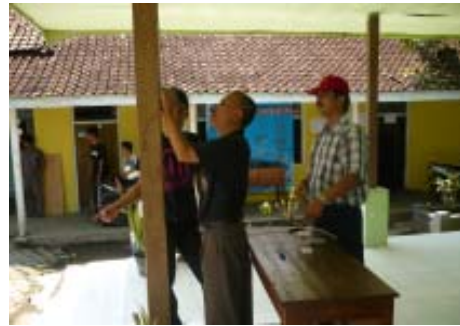
Gambar 8. Tim sedang melakukan pelaksanaan kegiatan praktek pemasangan instalasi dengan saklar, pengaman, kabel dan lampu secara benar
