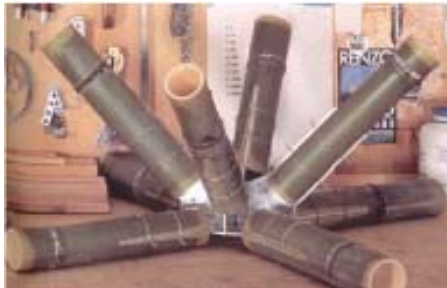
Gambar 1. Sistem sambungan konstruksi bambu
