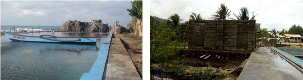
Gambar 9. Pembuatan kolam biota laut dan fasilitas sanitasi
