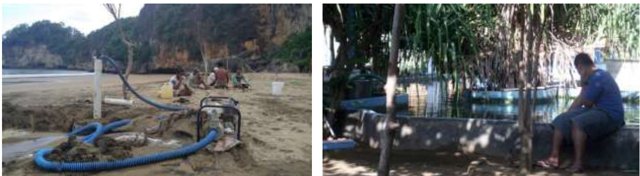
Gambar 7. Pembuatan sumur air laut untuk kolam penyu
