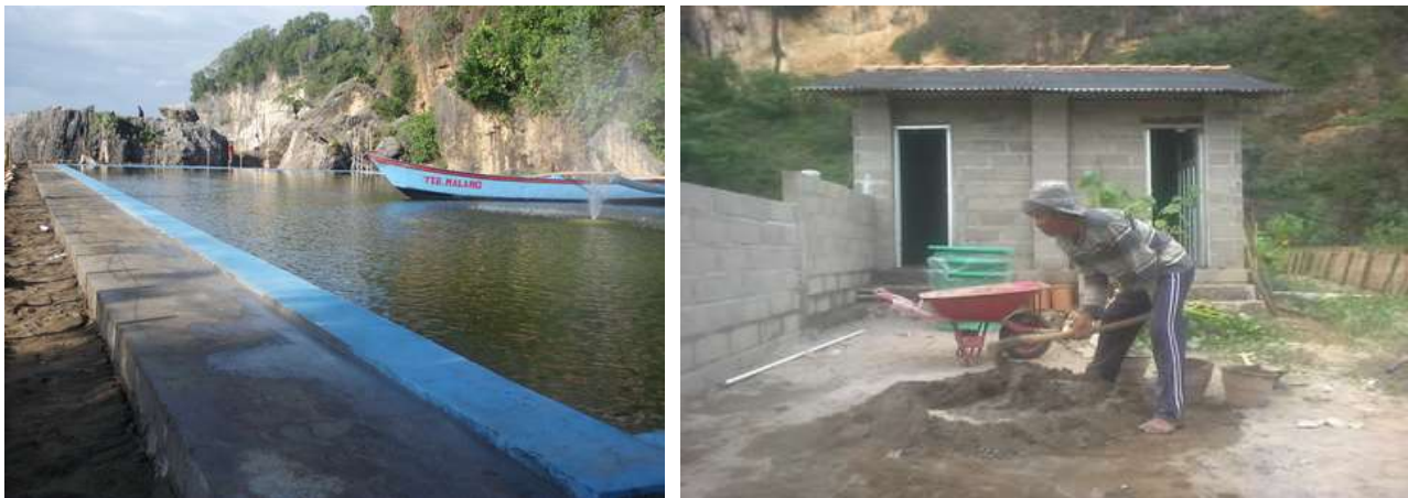
Gambar 14. Sisa pekerjaan kolam biota laut
