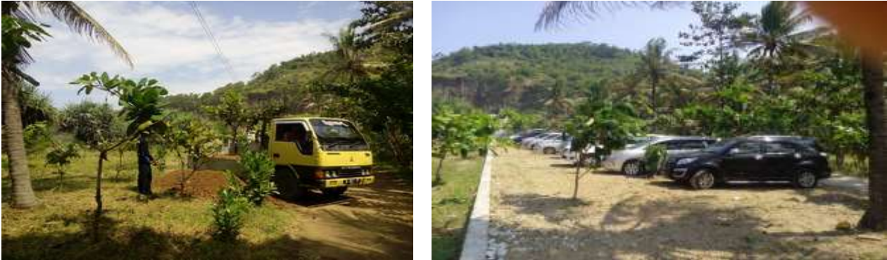
Gambar 11. Pembangunan lahan parkir
