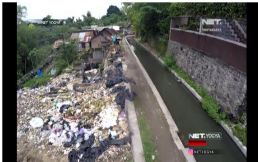
Gambar 1. Kondisi Bendung Lepen Gajah Wong sebelum direnovasi (Dokumentasi NET. TV)
