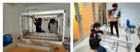
Gambar 7. Proses Perakitan Kerangka Prototipe Mesin 3D Printer
