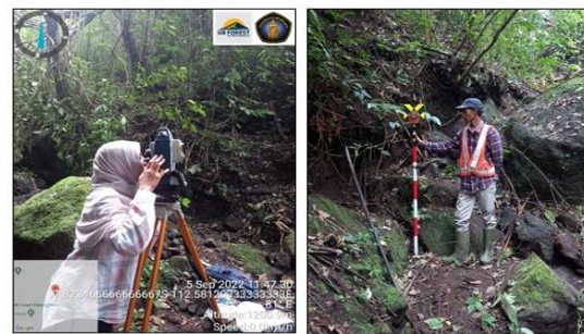
Gambar 3. Pelaksanaan pengukuran topografi di lokasi potensi embung
