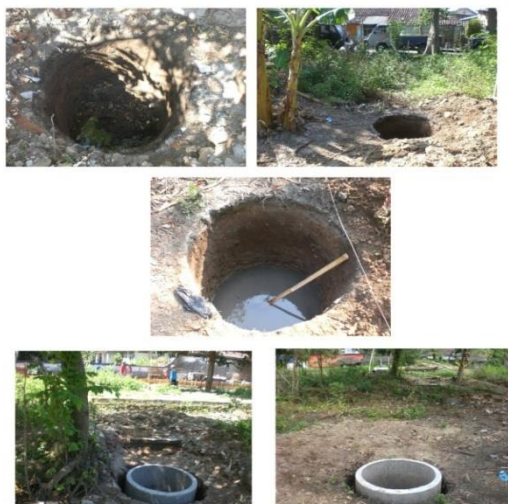
Gambar 3. Pembuatan Sumur Resapan
