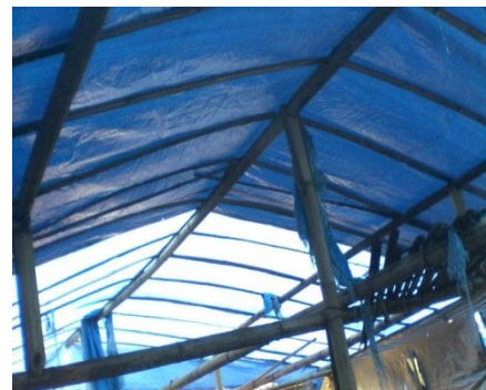
Penutup Atap Setelah Pemberian Fasilitas
