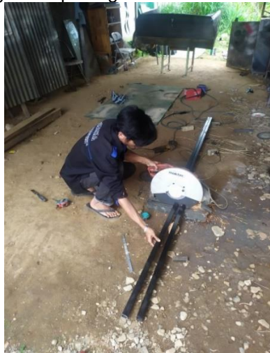
Gambar 4. Pemotongan baja profil
